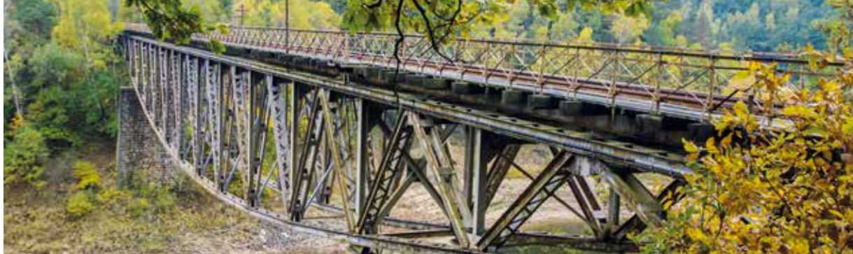
Zabytkowy most kratownicowy nad Bobrem / Historic steel bridge over the River Bóbr
