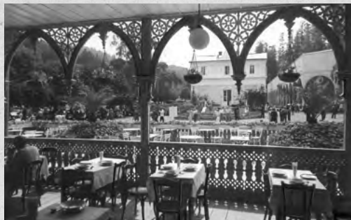
Weranda restauracji zdrojowej w Iwoniczu-Zdroju, w głębi budynek Starych Łazienek, 1939.
