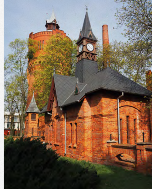
Stacja pomp Stare Bielany.
