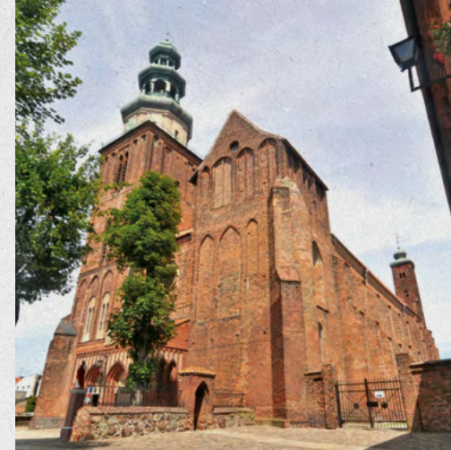
Katedra św. Trójcy w Chełmży to także przykład ceglano-gotyckiego stylu.
