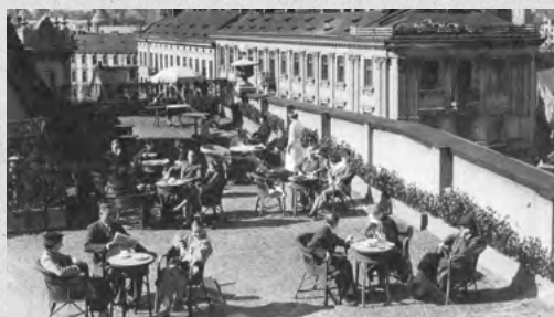
Na dachu budynku mieściła się kawiarnia Bar pod Słońcem, z której można było podziwiać panoramę Warszawy.
