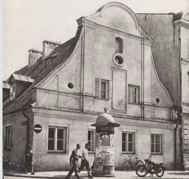
Barokowa kamienica przy ul. Grodzkiej 2, tu w latach 60. XX w. mieszkał Stanisław Staszewski.
