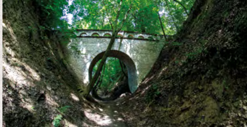
Mostek nad Wąwozem Śmierci łączący dwie części cmentarza w Kazimierzu Dolnym.
