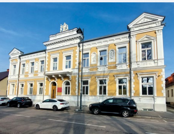
Pałac Tryllingów powstał pod koniec XIX w. w stylu eklektycznym. Fot. Katarzyna Pierwienis.
