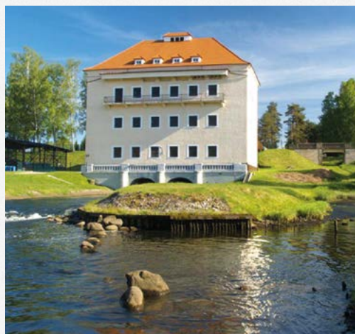
Elektrownia wodna w Krzyni.
