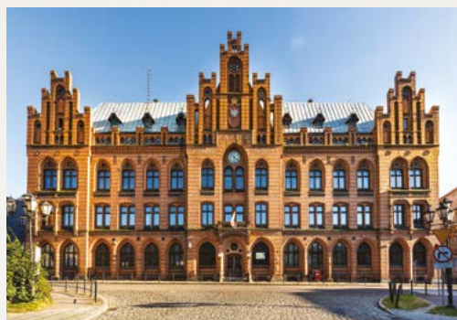
Neogotycki budynek poczty głównej z 1884 r. Fot. Adobe Stock.
